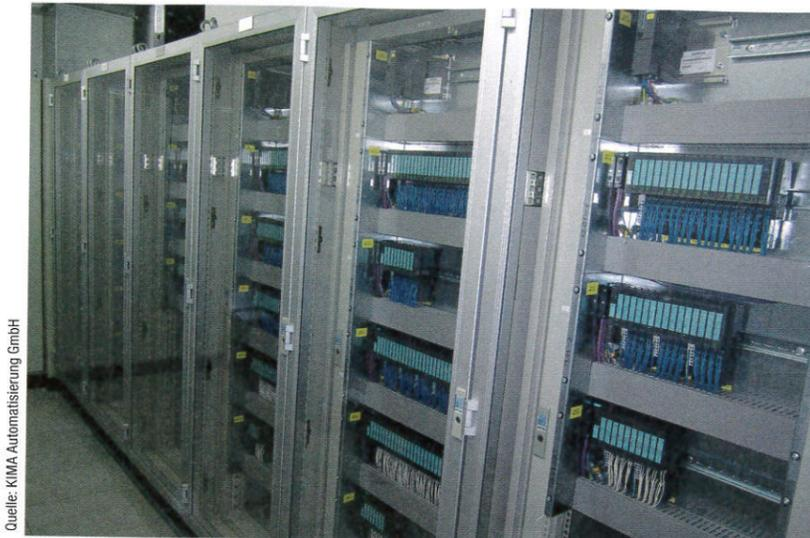
Abb. 6: Schaltschrankzeile nach erfolgtem Umschluss auf die neue S7-Technik
